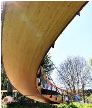
Abb. 5.1 (links) Gekrümmtes Verbundbauteil aus BS-Holz
