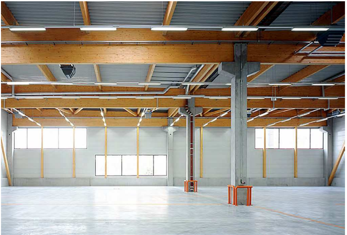
Abb. 1.3 Logistikzentrum mit Haupt- und Nebenträgern aus BS-Holz
